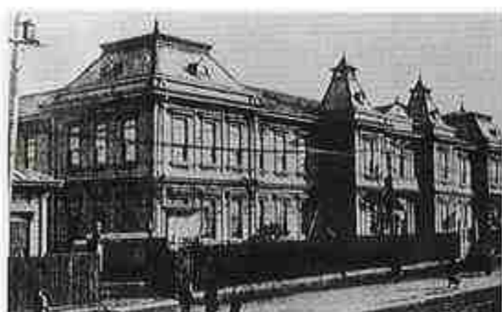
明治41年に完成した岩倉鉄道学校校舎全景
